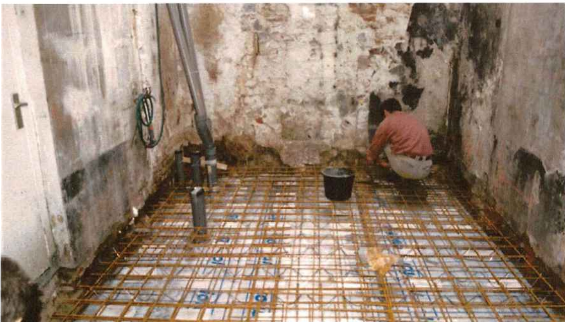
Foto uit de periode 1999-2000 waarop te zien hoe het betonstaal ten behoeve van de betonnen plaat gemaakt werd en hoe de betonnen plaat werd ingekast.
