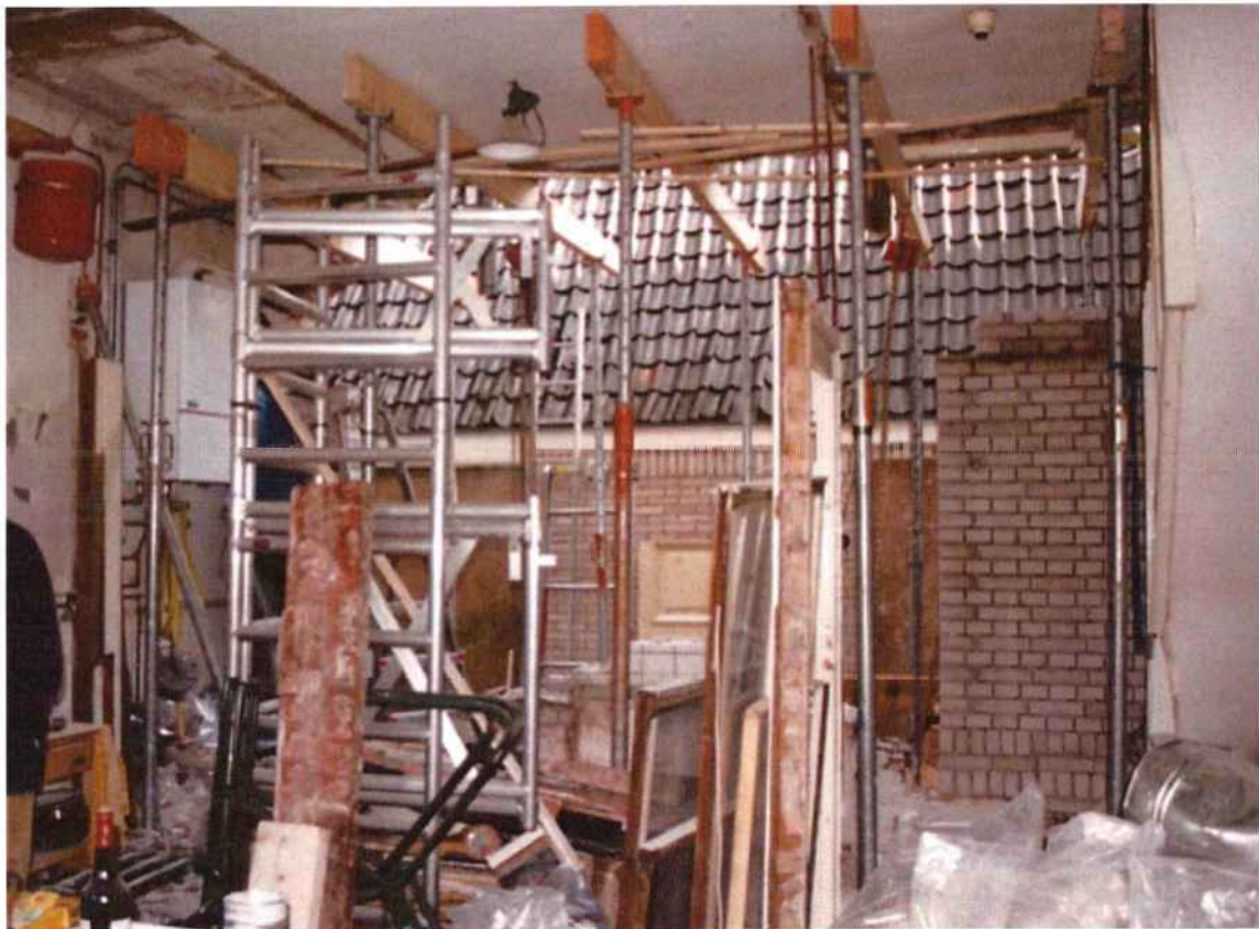
Foto uit de periode 1999-2000 dat aantoont dat de achtergevel ter hoogte van de eerste verdieping van Oudegracht 230 compleet was verwijderd.
