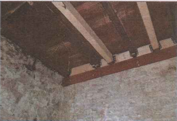
5. huiskelder; houten constructie met langsdragers
