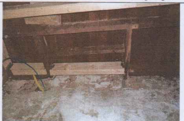
6. huiskelder; dichtgetimmerde raveling t.b.v. licht
