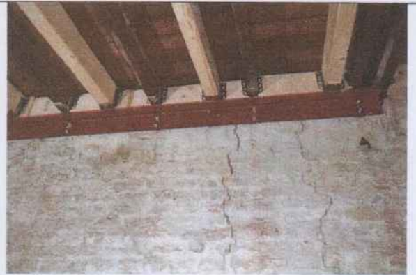
4. huiskelder; houten constructie met langsdragers
