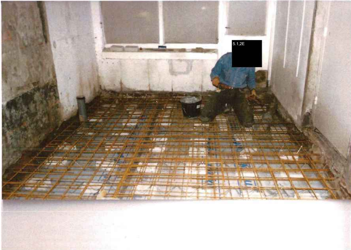
Foto uit de periode 1999-2000 waarop te zien hoe het betonstaal ten behoeve van de betonnen plaat gemaakt werd. Daarboven werd de aanbouw van Oudegracht 230 gerealiseerd.
