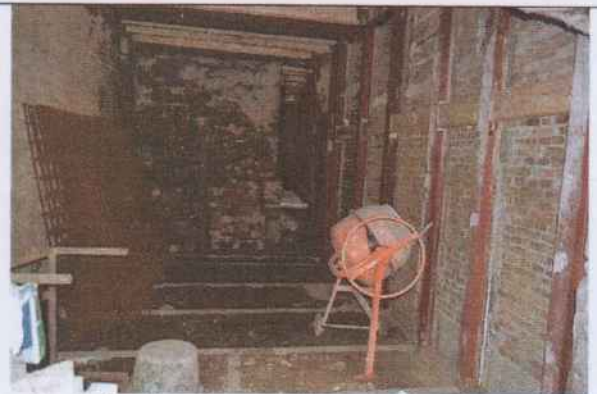
2. huiskelder; nieuwe keldermuur en stalen constructie
