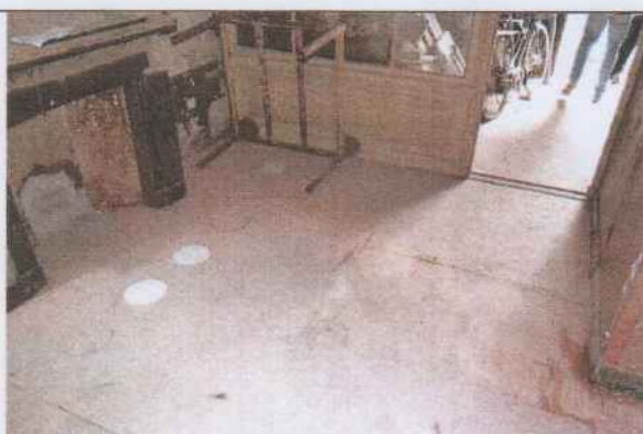
21. begane grond; dichtgelegde gaten in vloer
