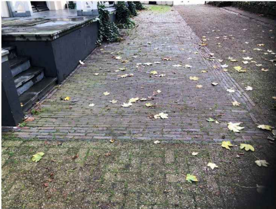
Bestrating waaltjes en betonklinkers
