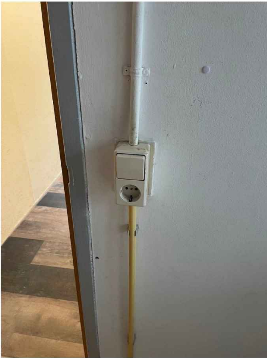
Kamer 5 : aardedraad vanuit kamer 4 doorgetrokken naar kamer 5 plus trekontlasting.
