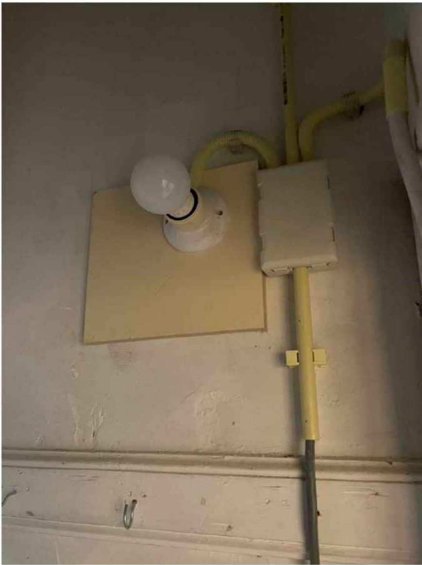
punt 13 losse lamp vastgezet op plaatmateriaal.
