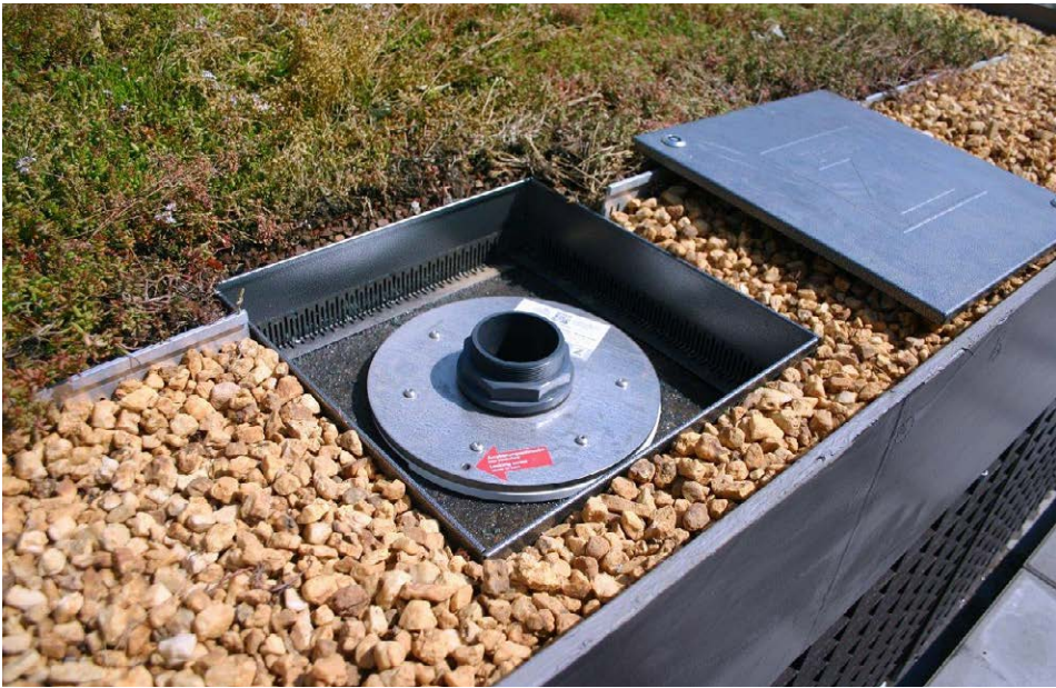
Passieve retentie, handmatig in te stellen waterbuffering met behulp van de run-off control.
