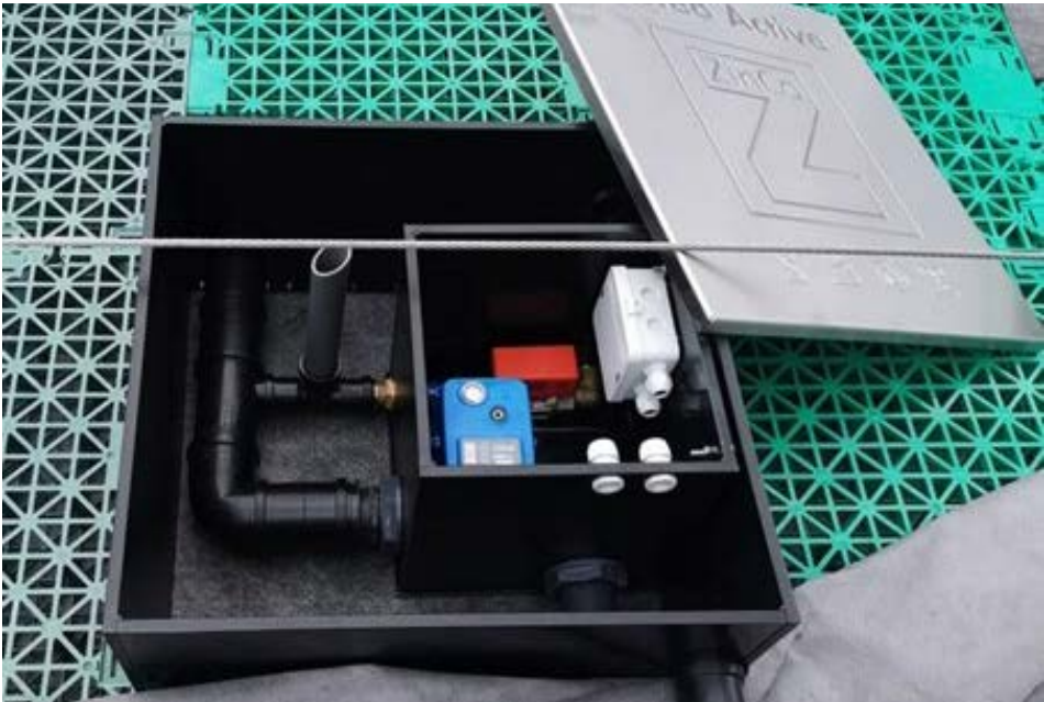
Actieve retentie gestuurd door middel van het MeteoActive systeem. Af - en toevoer wordt op afstand gestuurd.
