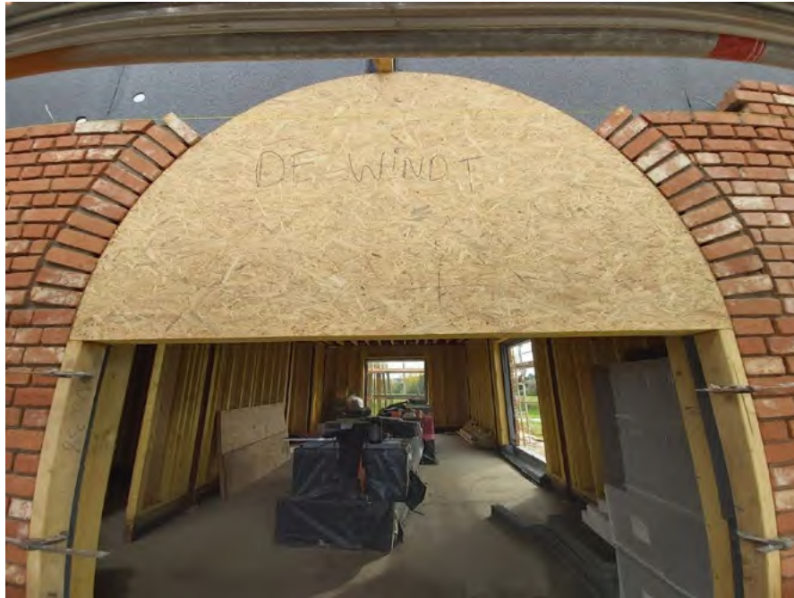
in het werk met mal
