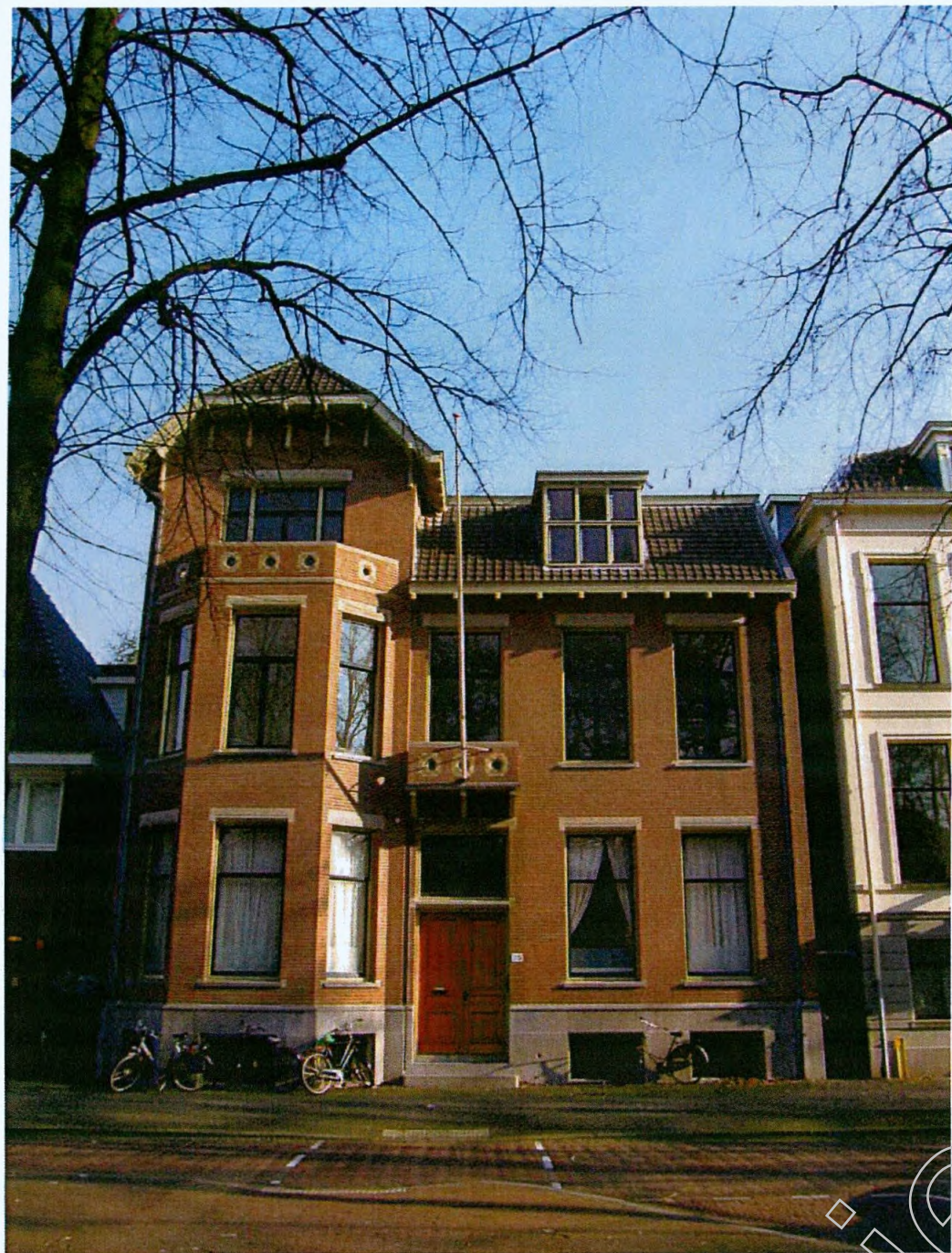
Foto voorgevel, bestaand Maliebaan 35, Utrecht
