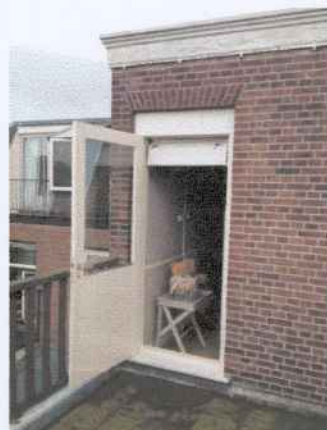
nachtegaalstraat 44 achtergevel bovenwoning
