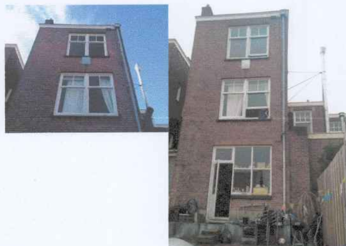
nachtegaalstraat 42 achtergevel bovenwoning
