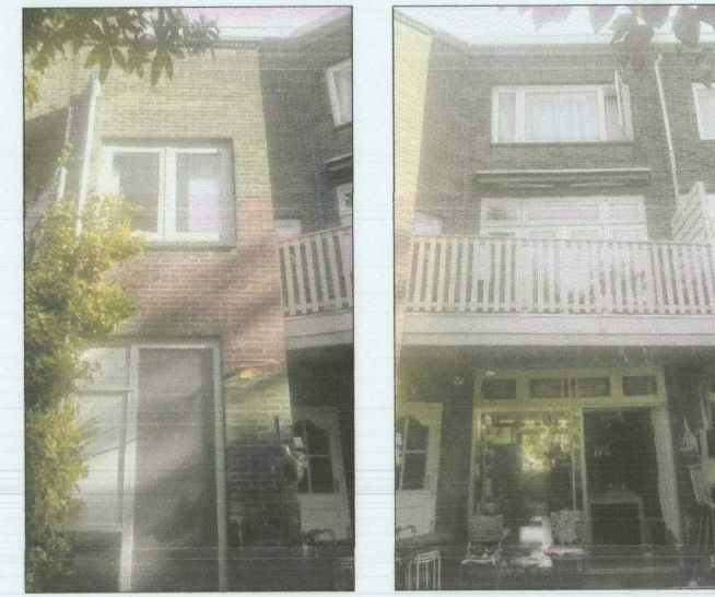
FOTO aanzicht achtergevel
