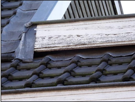
Fig. 2.4 Dak voorzijde, met loodflap zichtbaar als afwerking (bron: FF Solutions)
