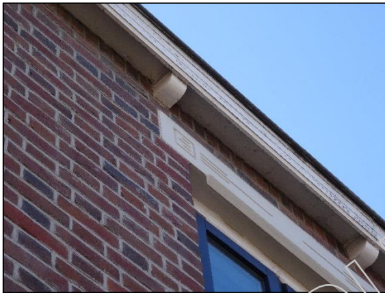
Fig. 2.6 Dakoverstek voorzijde woning, geen spleten zichtbaar (bron: FF Solutions)
